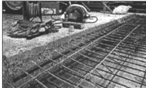
Beton de structura
