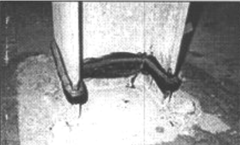
In jurul elementelor de structura din beton
